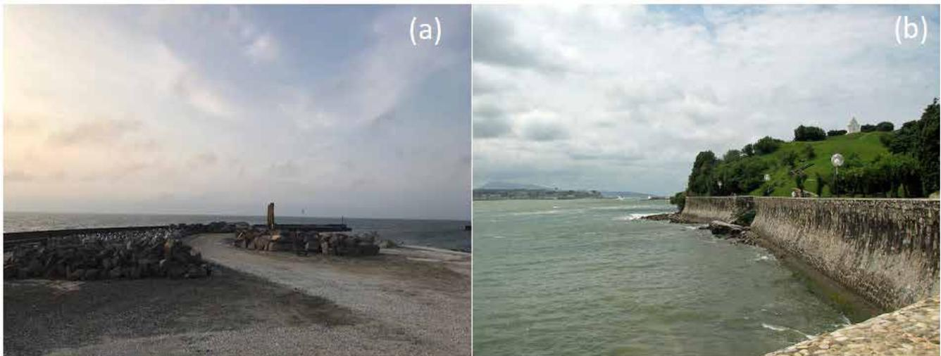
**Figure 2.** Structures côtières : (a) brise-lames en enrochement (Pilar Díaz-Carrasco, 2018) (b) mur vertical (Schotanus, 2008).
