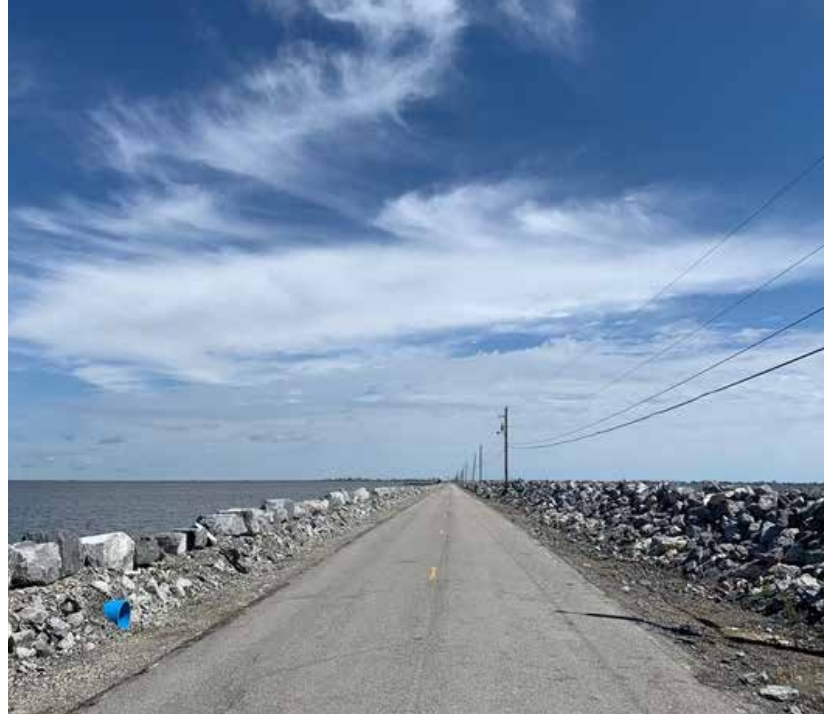
Figure 1. Island Road, la route menant à l'Isle de Jean Charles, traverse une immense étendue d'eau. Les murs en pierre ont été construits en 2021 pour protéger la route lors des ouragans. Source : Sarah M. Munoz, mars 2022.
