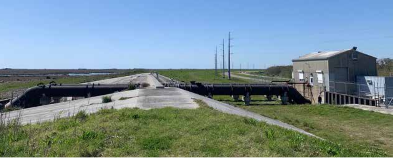
Figure 4. Station de pompage à Diamond permettant d'évacuer l'eau à l'intérieur de la digue (droite sur la photo) vers le golfe du Mexique (gauche). Source : Sarah M. Munoz, mars 2022.
